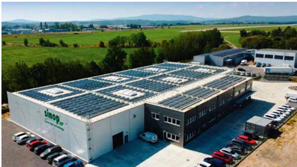
Obr. 2: Nová výrobní hala na výčepní zařízení f. Sinop CB a.s.
