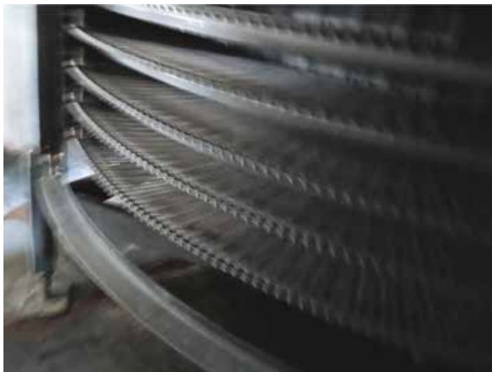
Obr. č. 5: pohled na jednotlivá patra dopravního pásu.
